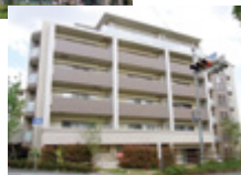
夙川賃貸マンション (兵庫県 西宮市)
