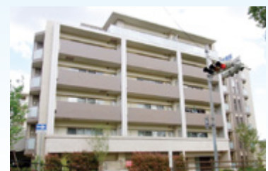
夙川賃貸マンション (兵庫県西宮市)
