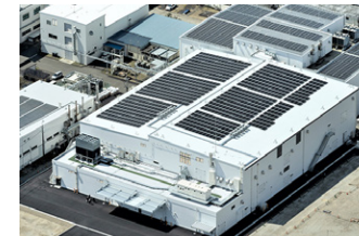
拡張したクリーン工場 （江南工場）
