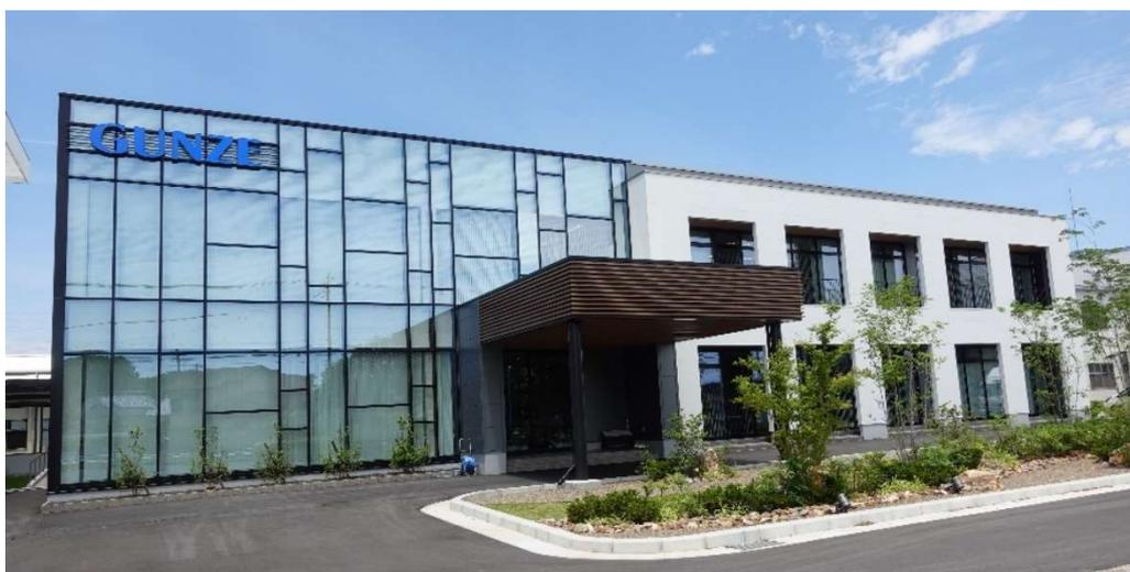
当社エンジニアリングプラスチックス事業の基幹である江南工場において、2023年3月にZEB認証を取得した事務所棟を本格稼働いたしました。当事務所棟はガスヒートポンプを採用した日本初の完全ZEB認証事務所（一般社団法人日本ガス協会調べ）であり、従来の建物で消費される一次エネルギーを基準に、削減率102%を実現します。
