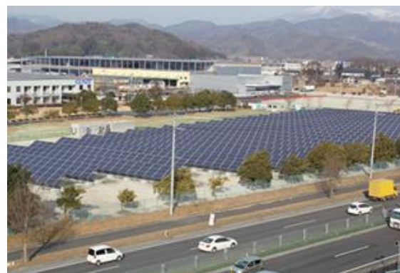
太陽光発電；福島県本宮市
