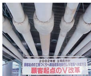
アスベスト除去前[宮津工場]
