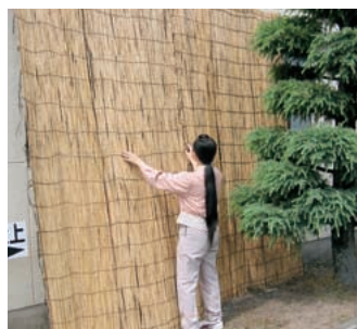
よし簾を設置[久世工場]
