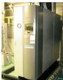
郡是高分子工業(株) LNG炊ボイラー
