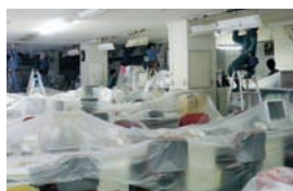
PCB混入蛍光灯安定器 撤去作業
