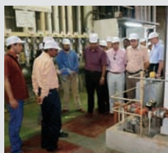
宮津工場の貫流ボイラー設備を見学するJICA研修生
