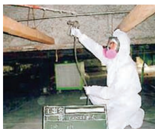
アスベスト除去作業[出雲アパレル（有）]
