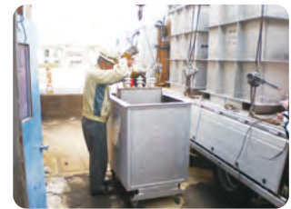
PCB撤去作業/出雲アパレル(有)
