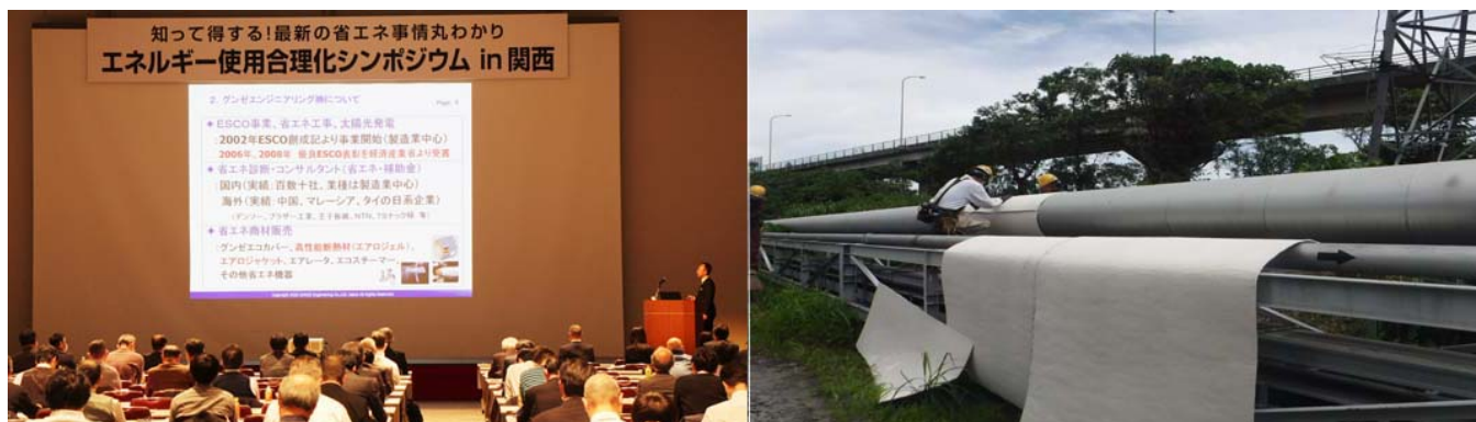
(写真左)シンポジウムにおける報告風景 (写真右) エアロジェルを活用した蒸気配管断熱施工例
