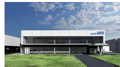
■ 第三工場事務所棟イメージ
