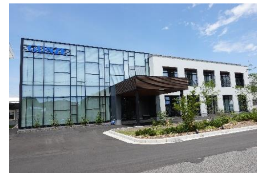
ZEB認証新事務所(江南工場)
