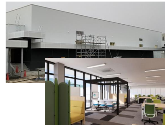
新工場（建設中）外観と、事務所イメージ
