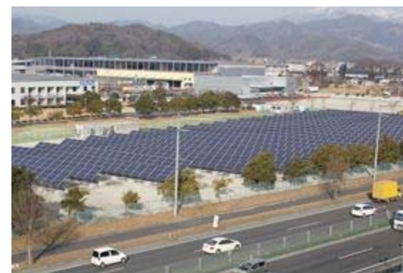
■ 太陽光発電(福島県本宮市)
